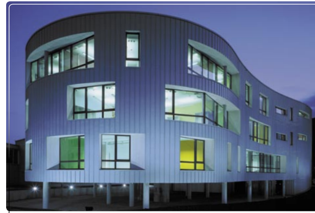
Bâtiment pour le développement et l'assemblage des systèmes de test AOI
